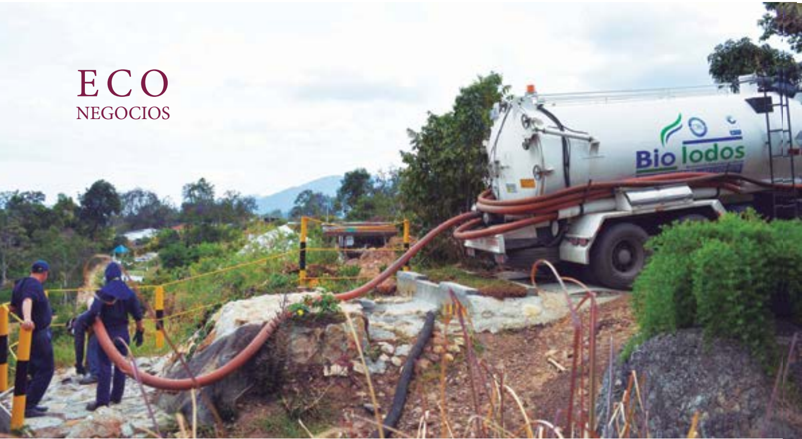
Zona de Recepción de Aguas, Parque Ambiental Biolodos Fusagasuga
